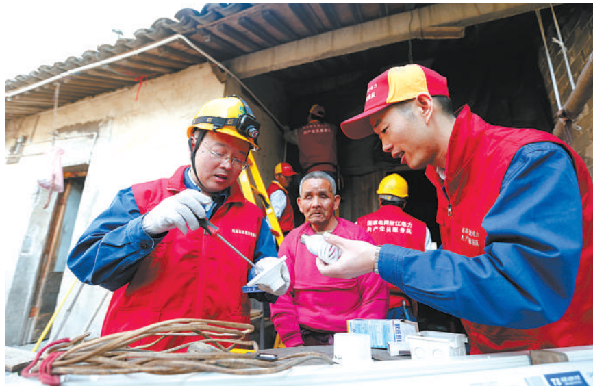
党员服务队正在为困难老人家里安装更换节能灯
