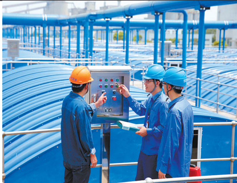
工作人员为宁波最大的污水处理厂检查用电安全情况
