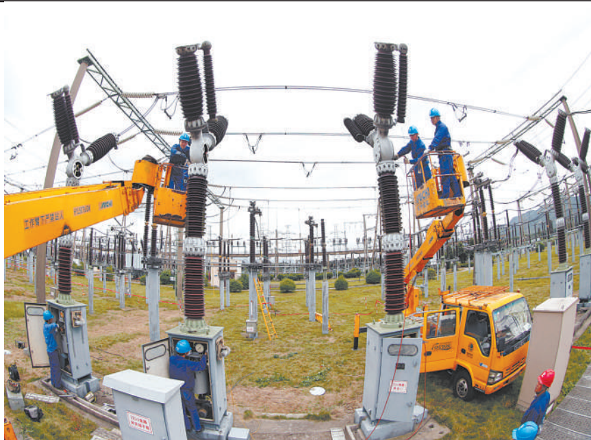
检修人员相互配合正在对旧断路器进行更换
