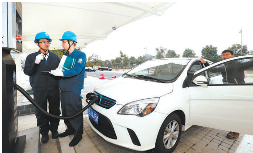
电力工作人员正在对充电情况进行分析测试
