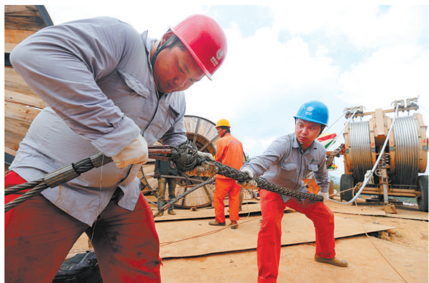
架线施工现场,工作人员正在对牵引导线进行安装
