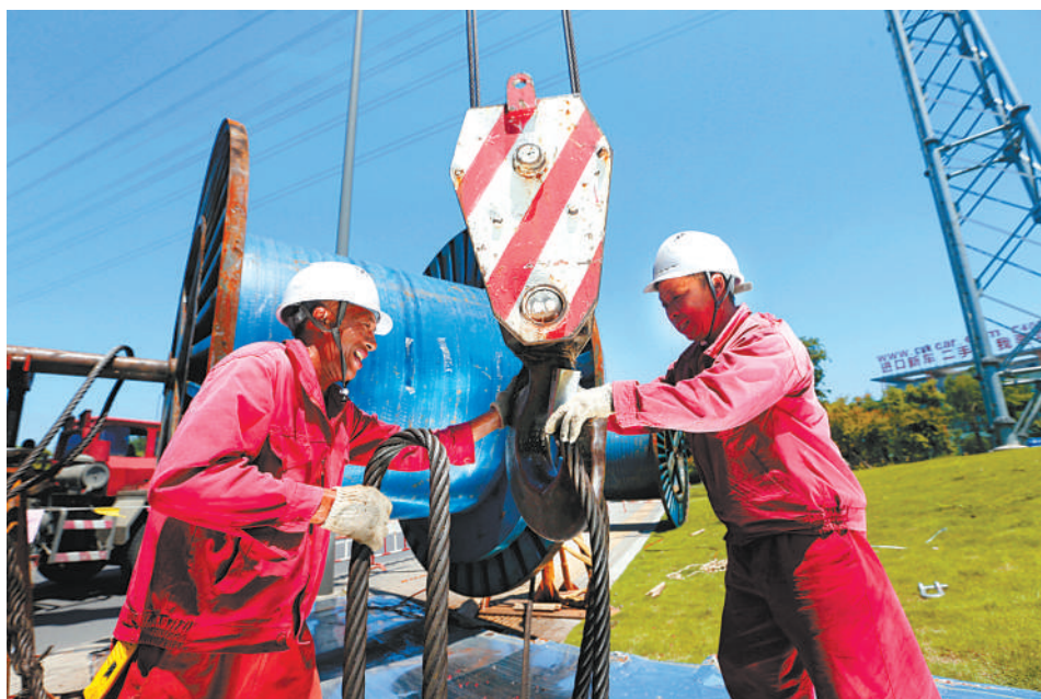
高温下,工作人员正在吊装新电缆盘
