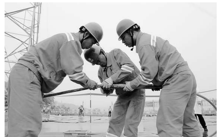
本次运动会涵盖了抢修检修、线路施工、变电调试、财务管理等13个大项。记者胡神 通讯员孙万鹏 摄
