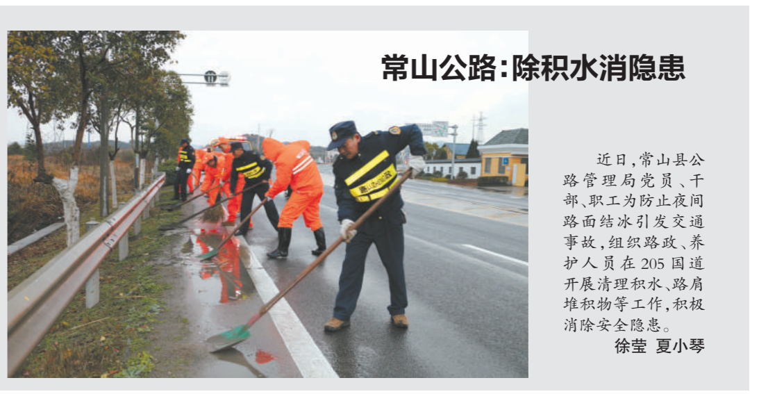
近日,常山县公路管理局党员、干部、职工为防止夜间路面结冰引发交通事故,组织路政、养护人员在205国道开展清理积水、路肩堆积物等工作,积极消除安全隐患。 徐莹 夏小琴
