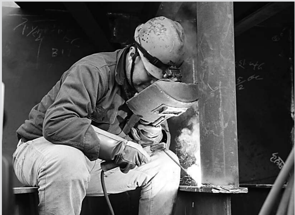
江苏泰州籍农民工李兴华正在焊接钢板。
