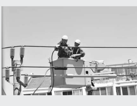
7月19日上午10时,骄阳似火。在桐乡市濮院镇凯旋路,国网桐乡市供电公司带电作业班钟兴、陈佳清顶着烈日,实施20千伏罗恒线25号杆跌落式熔断器上引线带电搭接作业,确保附近红晓新村新增630千伏安变压器工程顺利投产,让居民清凉度夏。据统计,今年上半年,桐乡供电公司已完成带电作业285次,多供电量965702千瓦时,减少停电户数23565户时。 冷丽华 彭艳珍
