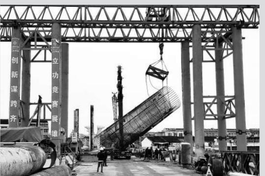
近日,经过全体施工人员48小时的努力,台州市路泽太高架TJ03标段清港直径3.2米超大灌注桩顺利浇筑完成。
