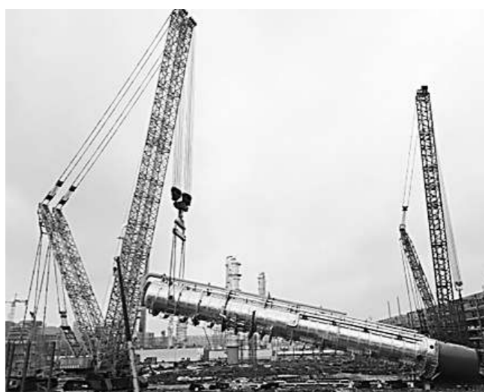
本报讯 记者羊荣江 通讯员李鹏报道 近日，浙江省工业设备安装集团有限公司第五分公司承建的浙江石油化工有限公司4000
