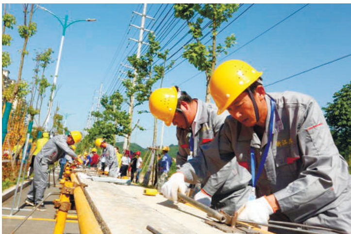
钢筋工比赛现场。
