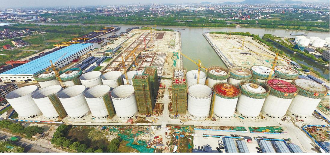
眼下,20个内径为26米、41.5米高的圆筒形粮仓在杭州运河边拔地而起。“粮仓的主体结构施工已经全面完成,即将进入结顶阶段。”负责项目施工的省三建建设集团仁和粮食储备库建设工程(标段一)项目负责人徐江利介绍。
