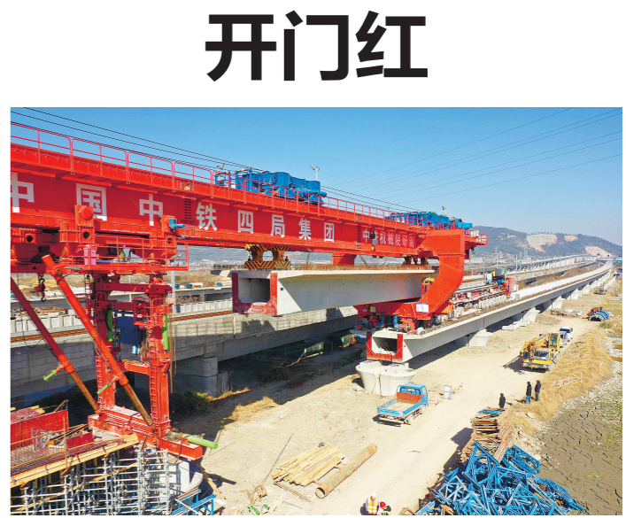
昨日，杭绍台铁路与甬台温铁路温岭站北端下行联络线特大桥最后一扣箱梁顺利架设。
