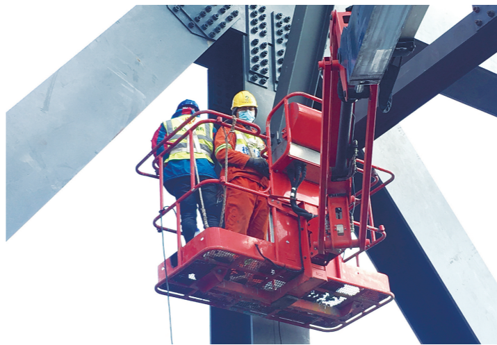
建设者正在衢江大桥改扩建工程忙碌。
