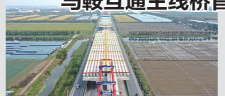
1月6日，在浙江省交通集团杭绍甬高速杭绍段项目马鞍互通主线桥施工现场，两台130吨吊机将一片跨径45米、重达37.3吨的钢板梁稳稳落在支座上，该桥首片钢板梁由此成功架设。
