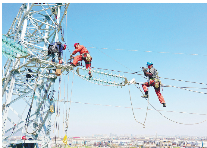
日前，温岭市箬横镇浦东村，电力工人在台州沙角110千伏输电线路最后一座转角塔基础上架设线路，近日将完成全线路架设。台州沙角110千伏输电线路工程建成后，将填补温岭中南部110千伏输电设施空白，优化完善全市电网结构，提高供电可靠性，满足石桥湾、城南、箬横等地新增用电负荷需求，促进经济发展。 通讯员刘振清摄
