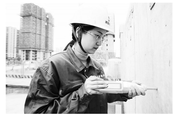
邓亚芬对施工墙体进行检测。
