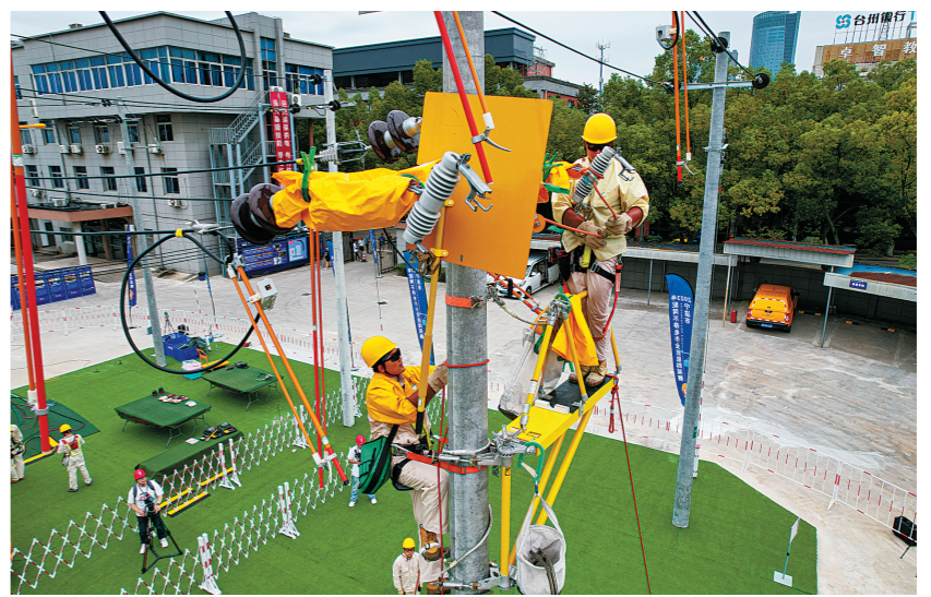
日前,2023年宁波市配网不停电作业群英赛现场实操在宁波拉开序幕。杭州第19届亚运会开幕在即,宁波拥有“亚洲帆船中心”和“沙滩排球中心”两座亚运会比赛场馆,在亚运期间保障稳定可靠供电,是国网宁波供电公司肩负的重大使命。此次竞赛通过展现风貌、切磋技能、相互交流学习,为储备不停电作业人才“蓄水池”进行赛场练兵,将以更扎实的技能投入到亚运保供电工作中。
