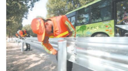
永康市去年总投资517万元，其40条农村公路安保工程治理计划，即危险路段的钢质防护栏的安装施工，现已进入扫尾，并在元旦前基本完工。这也标志着，永康市内的农村公路安保工程，经过8年来的治理，现已全部整治完毕。其间，为全市166条农村公路上的临水、临崖、高落差等危险路段，安装上钢质防护栏累计192617米，设置防撞墩6379个，以及钢筋砼防撞护栏590米等，总投资4338.7万元。图为永康市公路施工人员在画白线安装护栏场景。
