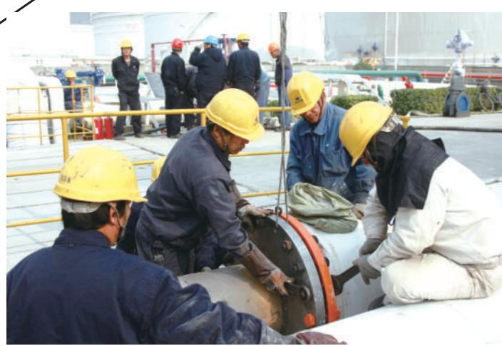
2月1日,由中化(舟山)兴海建设有限公司一线施工技术人员江维安创新发明并获得国家专利的“新型管道封堵技术”在岙山石油基地库区投入使用,由此解决了石化企业在对管道、阀门进行局部维修时需整条管线停产的问题。这是该公司今年投入使用的第二项员工发明专利技术。
