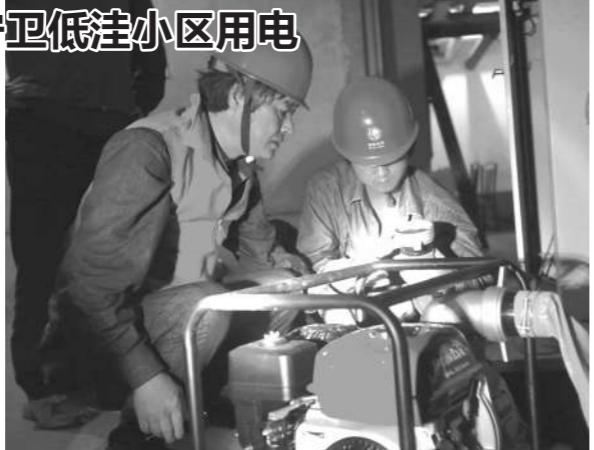
7月11日晚，虽然“灿鸿”台风渐行渐远，萧山区强降雨预期却没有消散。为此，国家电网浙江电力（杭州萧山钱江）党员服务队积极排查辖区内小区，发现部分地势低洼配电房因建筑年代久远，电缆管沟排水能力下降，管沟内因前几日降雨已有较高水位积水。为此，服务队员们搬来抽水泵，对管沟内积水进行抽送，防止后期雨水位上升，影响配电设施安全运行。
