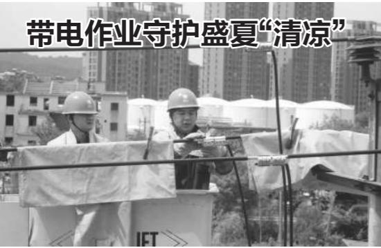
近日，在杭州市萧山区北干街道荣联村，国网杭州萧山区供电公司带电作业人员头顶烈日，站在带电作业车高高伸起的绝缘斗内，穿着厚厚的绝缘服，开展线路联络开关的搭接工作（如图）。据悉，带电作业在夏季显得尤为重要，电力工作人员在提升设备供电可靠性的同时，又不影响居民的正常用电。当天该次作业成功为周边3000余户居民守住了“清凉”。
