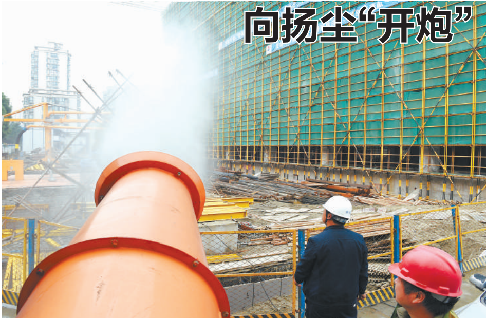
昨天上午,在杭州学院路省重点工程——浙江省职工服务中心项目建设工地一角,随着一声“开炮”令,一门被工人称为“雾炮”的喷雾式除尘设备瞬间喷射出一股股“浓雾”,直扑在建工地上的扬尘。据悉,为了最大程度地降低施工引起的扬尘,工地专门购来“大炮”喷雾降尘,确保环境清洁。
