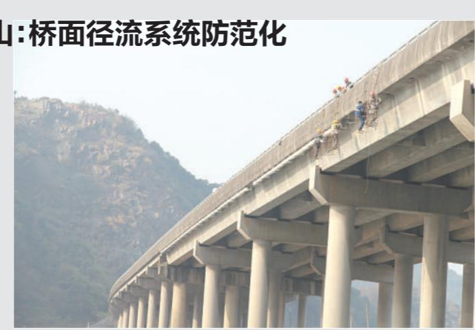
常山县2015年国省道桥梁面径流系统安装工程于11月20日开工，在国省道桥梁桥面上安装径流系统，能有效防止化学物品运输当中泄漏或洒落桥面流到水里的危害。这次常山县国省道涉及安装的桥梁面径流系统共有6座，工程造价为223万元，预期春节前全部完工。图为320国道长坪大桥施工现场。
