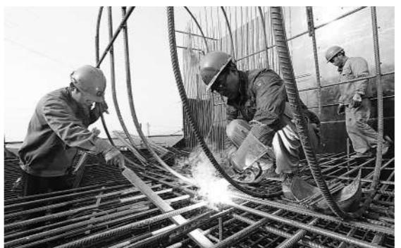
柯桥区总工会围绕“六比六赛”,即比质量、赛工程;比安全、赛技术;比进度、赛科学;比效益、赛精益;比创新、赛技术;比廉洁、赛廉政,积极推进重点工作工程立功竞赛活动,努力为建设“时尚柯桥、印象柯桥、幸福柯桥”添砖加瓦。图为省重点工程钱滨线施工现场,建筑工人正在加班加点焊接绑扎腹板底板钢筋。
