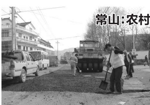
镇的农村公路大中修路面事项,并进行现场指导。 常山县中球线农村公路大中修工程,主要是为县道破损路面加宽、改造,其中沥青路面修复6496平方米,混凝土路面修复2418平方米,工程从2015年6月开始,投资275万元,预计这周完工。 徐莹 汪诚 摄
