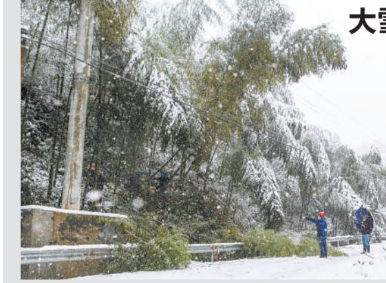
1月21日上午起,鹅毛般的雪片密集地洒落在富阳大地,层层覆盖在银装素裹的村庄上、山林上,不少被积雪压断的毛竹横倒在路边或高压线上,成为特殊天气下电网安全运行最主要的隐患。为此,富阳供电公司19支抢修队伍380余名一线抢修人员开始了全力总动员,备战此次寒潮大雪。图为在富阳区毛竹之乡常绿镇,电力抢修人员正在修剪压线和隐患毛竹。经过近两个小时奋战,当天下午1时该区域受雪灾影响停电村庄全部通电。
