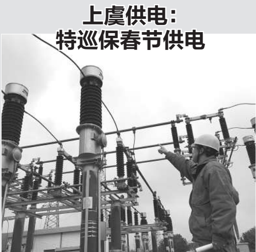
2月2日,国网绍兴市上虞区供电公司变电运维人员正在35千伏下管变巡视设备。春节来临,该公司在按期正常巡视的基础上,组织全体值班人员进行特巡,每天派出两组甚至三组轮流巡查,重点关注设备有无冰冻等现象,共排查出3项重要缺陷并上报消除。 范建庆 摄
