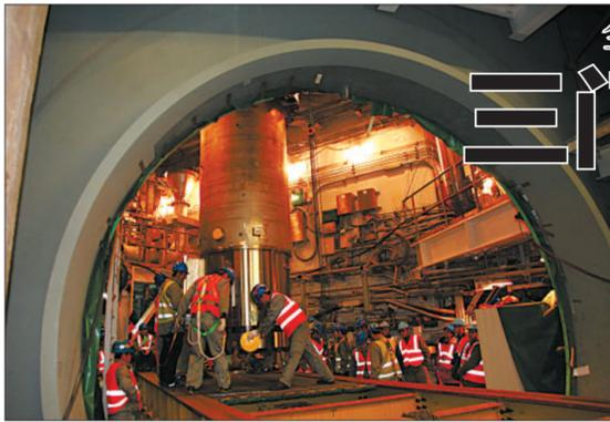
三门核电1号机组第一台主泵吊装场景。
