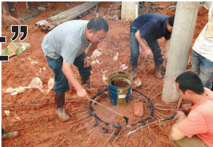
郦云平(图左)正在进行导航设备反射网施工。
