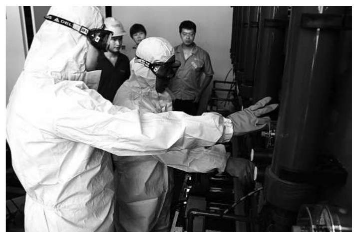
进行现场投料操作及安全防护措施等培训,帮助其熟练掌握计量泵、储药罐、加药管路的使用与管理,使加氯消毒更加标准化、规范化。
