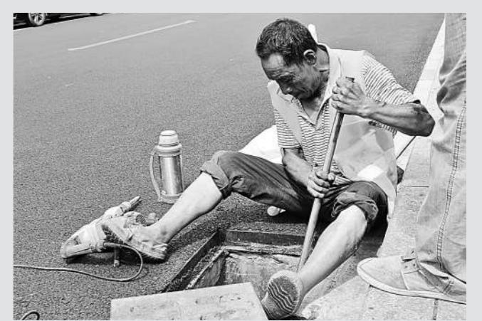
8月8日上午，烈日当空。在杭州江城路抚宁巷路面上，一位民工半蹲在雨水井里，整个脸几乎与火热的柏油路面贴在一起了（左图）。这位民工姓江，来自江西，年近五十。江师傅说，这里的路面刚铺浇过沥青，一些沥青砂石从雨水井盖的漏水口掉下去并且凝固了，现在要用冲击锤（右图）、铁锹、铁铲等工具击碎后，赶紧取出来，不然的话雨水井会堵塞的。说到热、说到辛苦，被太阳晒得红黑、红黑的江师傅微微一笑回答，这么高温的天干活怎么会不热？赚钱哪有不辛苦的？向在烈日下辛勤劳动的民工兄弟致敬！
