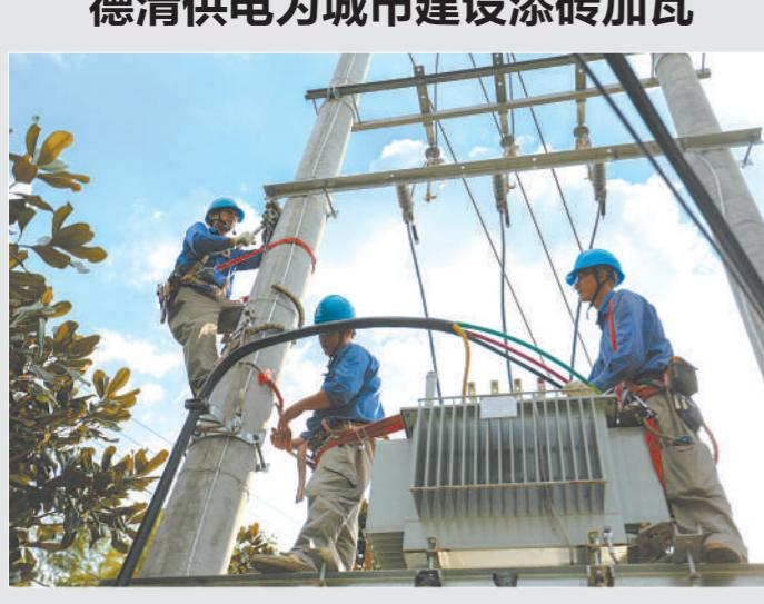
10月11日的德清晴空万里,在当地下渚湖街道,几名电力工人正爬在门架上为下渚湖附近的一台变压器进行增容改造(图)。今年,德清县提出打造国际化山水田园城市,加快推进具有德清特色的美丽县城建设。为此,国网德清县供电公司紧紧围绕相关建设要求,今年以来加大了对下渚湖、莫干山、新市古镇等旅游地老旧线路和设备的改造力度,对旅游热门区域进行提前布点增容,不断优化电网规划建设,提升优质服务水平,为德清国际化山水田园城市建设添砖加瓦。
