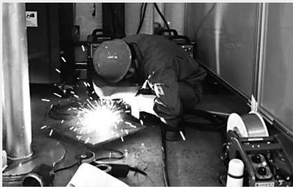
日前，由省总工会等举办的2016年浙江省建设行业职业技能竞赛焊工赛区决赛中，浙江省设备安装集团的三名选手，“一枪”包揽前三名，并被授予“浙江省技术能手”、“浙江省青年岗位能手”等荣誉称号。来自全省各市10个代表队的30名选手进入决赛。 记者周金友 通讯员李鹏 摄
