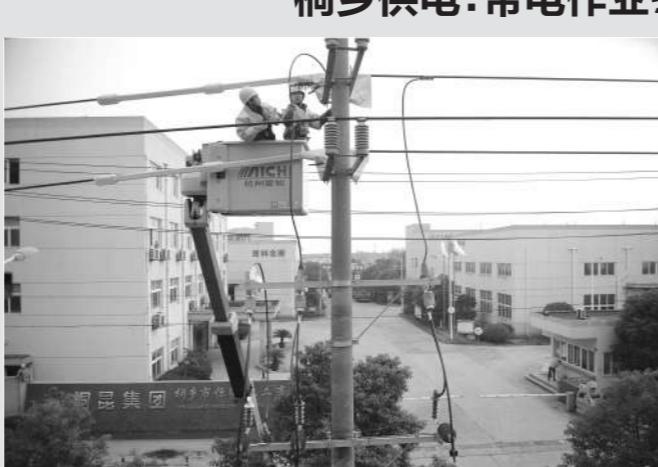
1月10日上午，在桐乡市洲泉镇产业园区，国网桐乡市供电公司带电作业班工作人员冒着寒风开展不停电作业，为20千伏双村S903线24号杆进行带电接跌落式熔断器上引线工作，确保了该条线上44家用户的正常用电。据悉，2016年桐乡供电公司始终坚持“能带不停”的工作理念，大力实施带电作业，累计开展带电作业186次，减少停电时户数14091.5户时。
