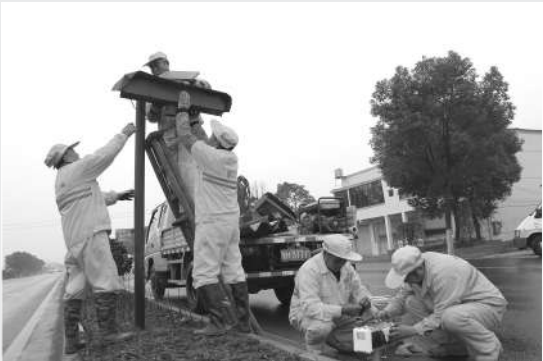
图为2月5日,320国道方村路段,养护工人正在更换损坏的爆闪灯。
