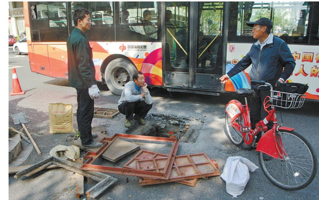
昨天上午,杭州江城路上,一位骑红色公共自行车的退休工人对赶来抢修破裂地下电缆井盖的师傅们说,“我发现这个隐患就打电话‘报告’了”。他说,这里是公交车出站必经之路,要是轮胎压住破裂的铁盖后“反弹”出去,不管是砸着车辆,还是行人,后果都很严重。这位退休工人还指着已经掀开的井盖说,井盖的“基坑”没按规范施工,是井盖常被压裂的原因之一。
