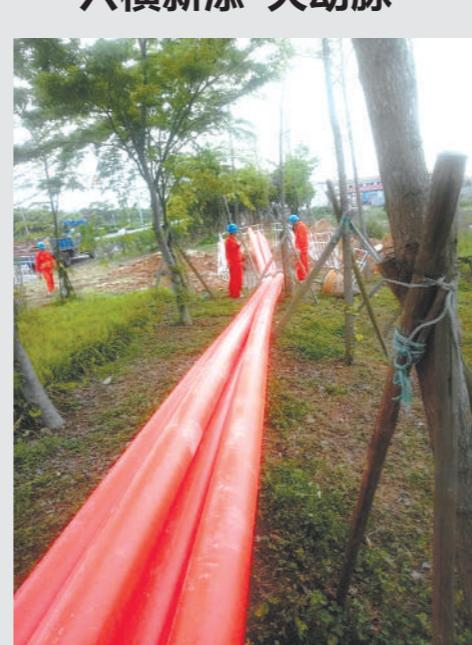
5月11日,舟山供电公司六横供电所工作人员在双塘铺设管线,忙碌开展六横110千伏港兴变与双屿变10千伏联络线新建工程(如图)。工程完工后,将实现港兴、双屿两变联络,进一步保障六横蛟头、台门、双塘片区的供电可靠性,并为双塘南部开发做好电力准备。
