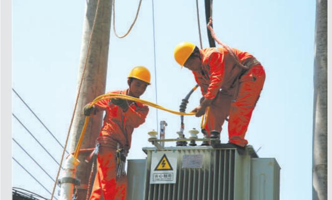
7月13日入伏第二天,绍兴市上虞区崧厦镇城际广场,国网绍兴市上虞区供电公司员工正在对变压器进行增容改造。据悉,当天共架线375米,跨河拆旧线18档,新增配电容量150千伏安。改造后,周边用户将能享受到充沛电力带来的无忧清凉。
