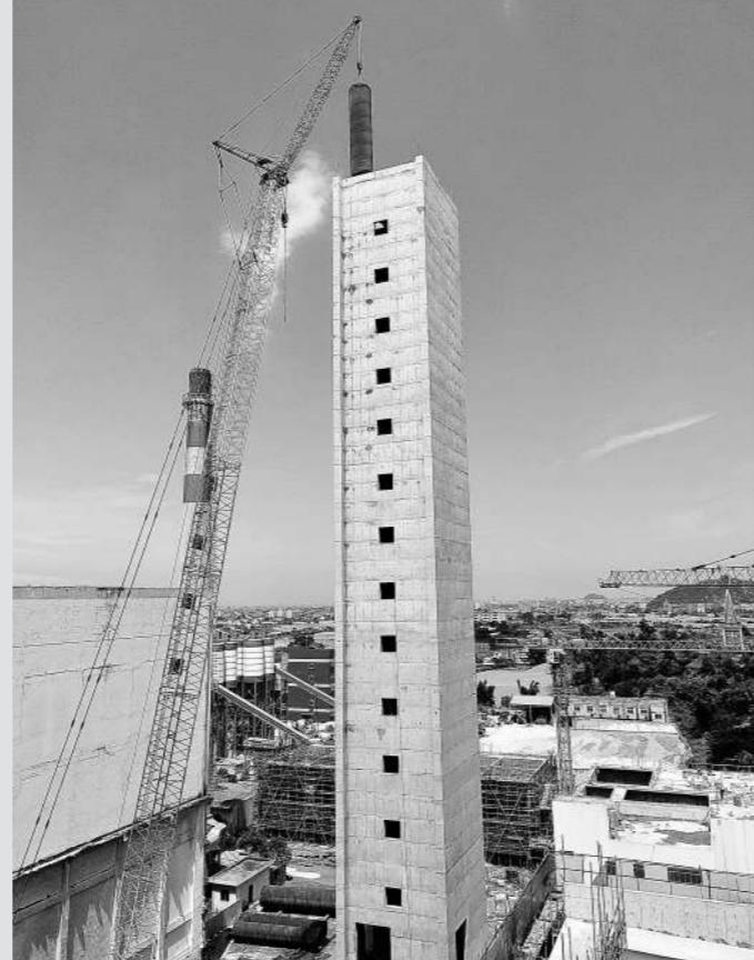
近日,浙江省工业设备安装集团有限公司第四分公司承建的温州苍南云岩发电项目3根(每根80米高)钢制烟囱吊装圆满完成。
