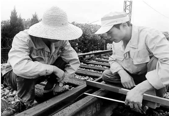
方俊畅(右)在师傅指导下检查道岔几何状态。
