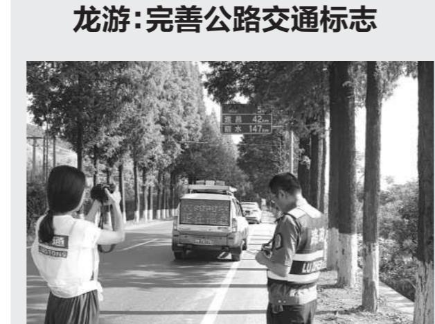
近期,龙游县公路管理局路政人员对320国道、222省道、315省道、316省道的指路标志、限速标志进行全面排查登记。对交通标志版面设置、结构形式、板材、反光膜、立柱、横梁、基础等方面逐一排查,不符合标准规范的立即整改,完善公路指路体系,提高公路服务水平。 陈伟
