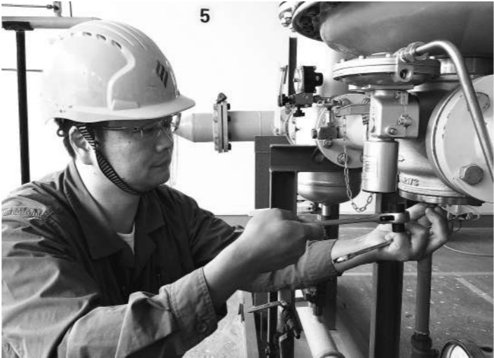
沈卫国正在排查燃气调压设备
