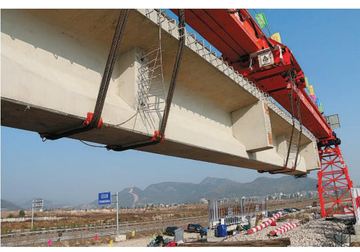
12月26日上午,随着TJ-165架桥机将T梁缓缓落在跨疏港公路特大桥39~40号桥墩上,乐清湾港区铁路支线工程首孔桥梁架设宣告成功,标志着该项目建设
