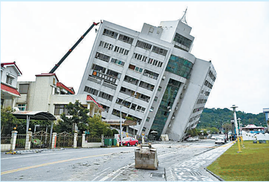
这是倾斜倒塌的云门翠堤大楼(2月7日摄)。
