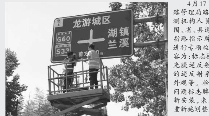
4月17日,龙游县公路管理局路政科会同检测机构人员,对辖区内国、省、县道公路标线、指路指示牌、导向牌等进行专项检测。检测内容为:标志板材厚度、反光膜逆反射系数、标线的逆反射系数、厚度及外观等。检测中发现的问题标志牌将“下架”重新安装,未达标标线将重新施划整改。
