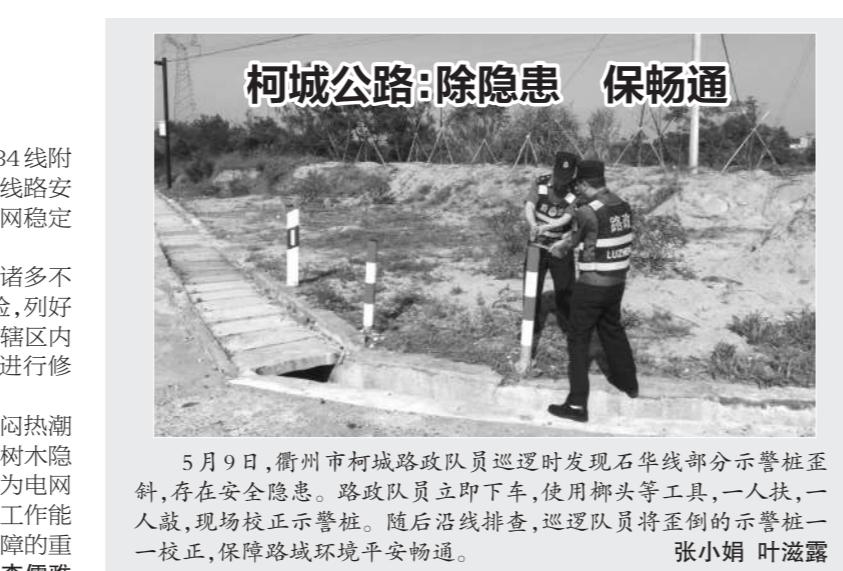
5月9日,衢州市柯城公路路政队员巡逻时发现石华线部分示警桩歪斜,存在安全隐患。路政队员立即下车,使用榔头等工具,一人扶,一人敲,现场校正示警桩。随后沿线排查,巡逻队员将歪倒的示警桩一校正,保障路域环境平安畅通。 张小娟 叶滋露
