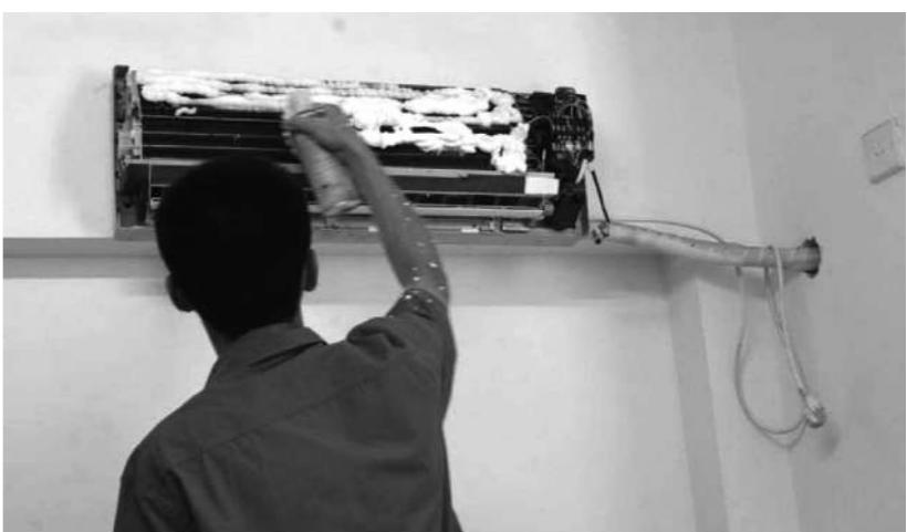
空调使用一段时间后,过滤网、蒸发器及送风系统上会积聚大量灰尘、滋生细菌,清洗空调成为空调养护的要点。
