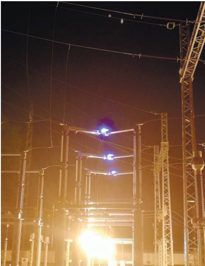
图片中的蓝光是所内设备受电冲击后产生的火花。
