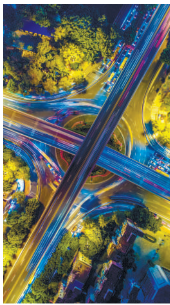
广州天河立交桥
