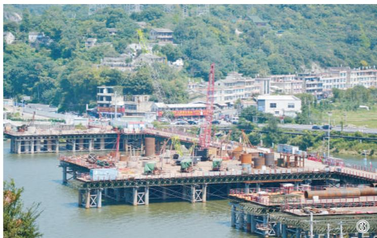
国庆期间,玉环漩门湾大桥及接线工程工地上,建桥工人们操作着机器,打钻桥墩桩基,以辛勤的劳动欢度国庆佳节(图③)。
