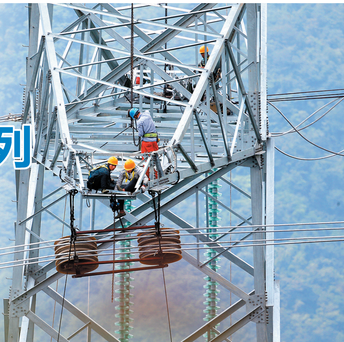
铁塔架线施工
