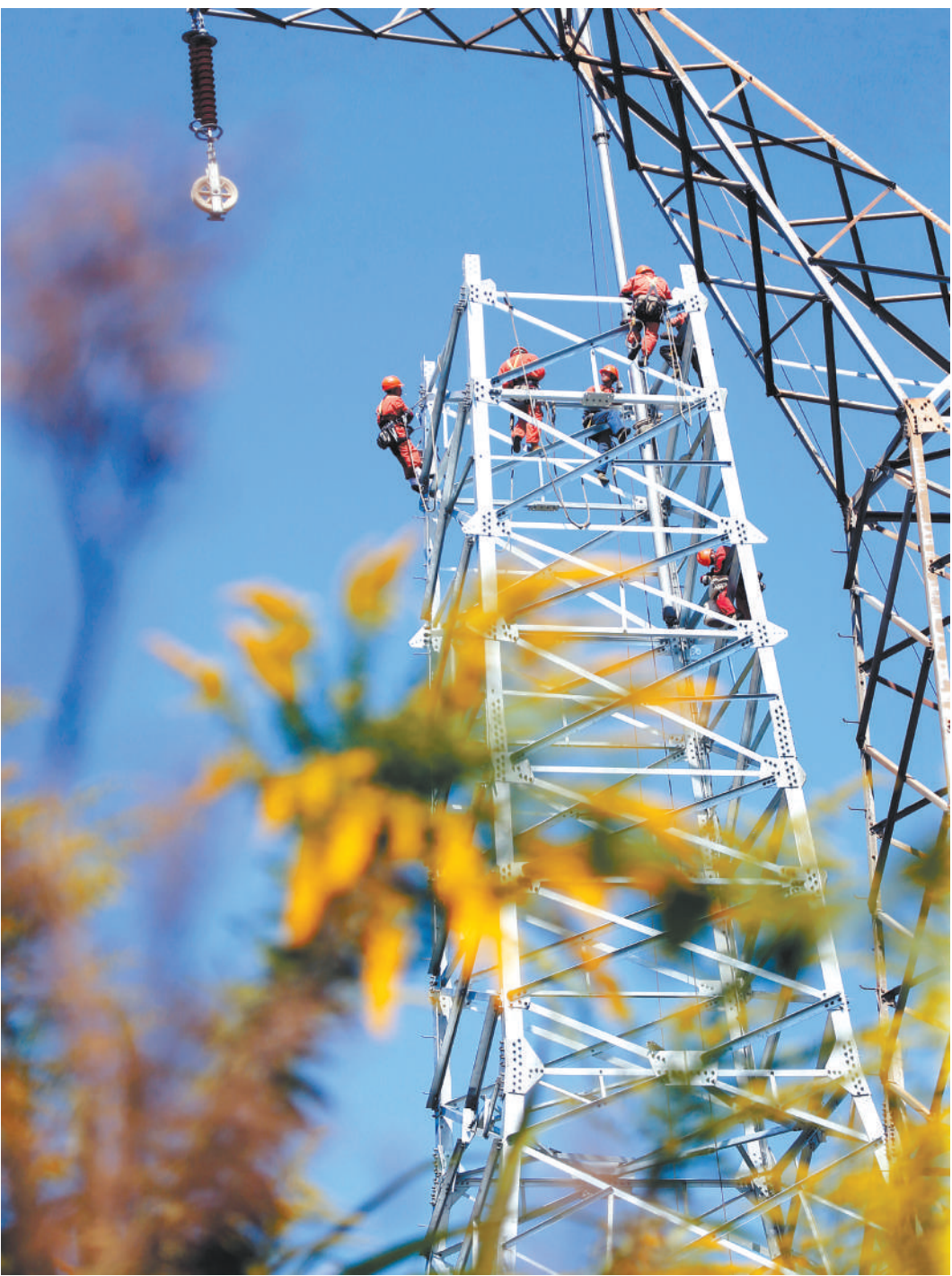
工作人员正在高空配合进行立塔施工
