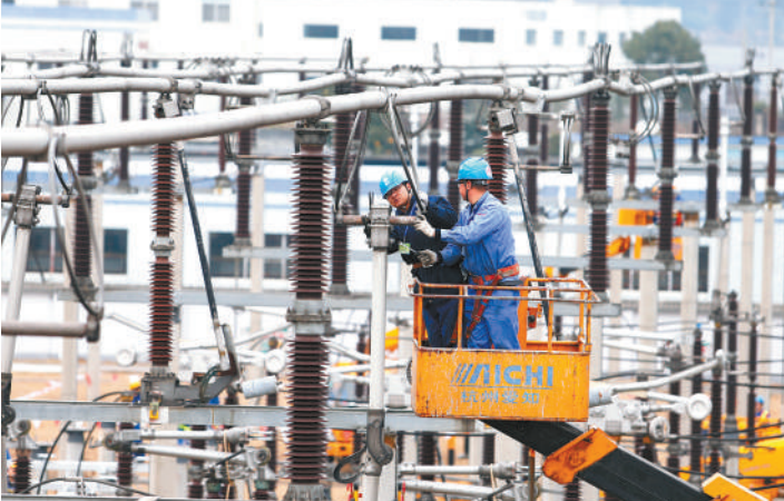
工作人员正在安装母线闸刀
