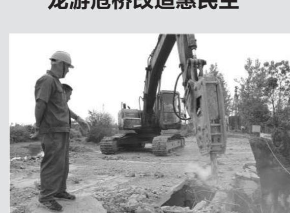
连日来,龙游县县道公路虎游线凤基冲危桥改造工地一片忙碌,建桥工人们忙着对封闭的老桥进行破碎凿除、桥台桩基打孔,以及钢筋笼制作。
